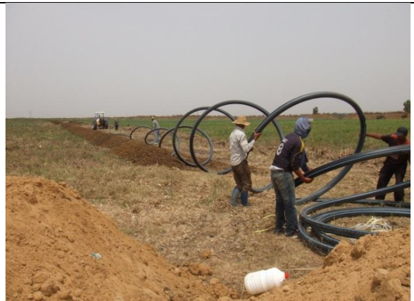
Fig. 5 : Mise en place de la conduite de raccordement secteur Nord 5 du Gharb
