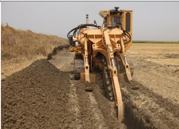
Fig. n°4 : Terrassement de tranchées pour la conduite de raccordement au niveau du secteur Nord 5 du Gharb
