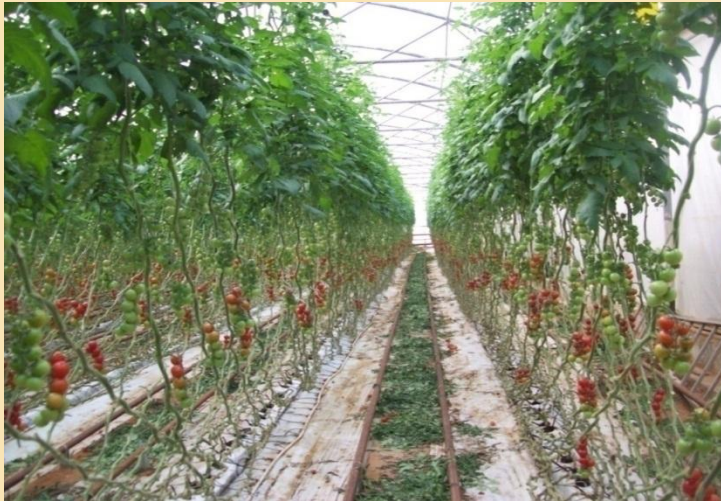
Dispositif cultural avec le réseau de chauffage
