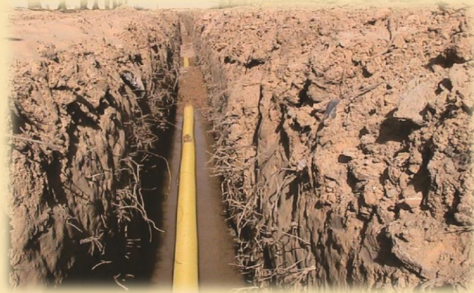
réseau de drainage
