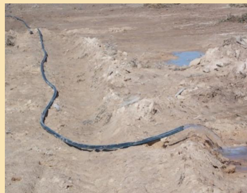
Evacuation de l'eau de drainage par pompage solaire
